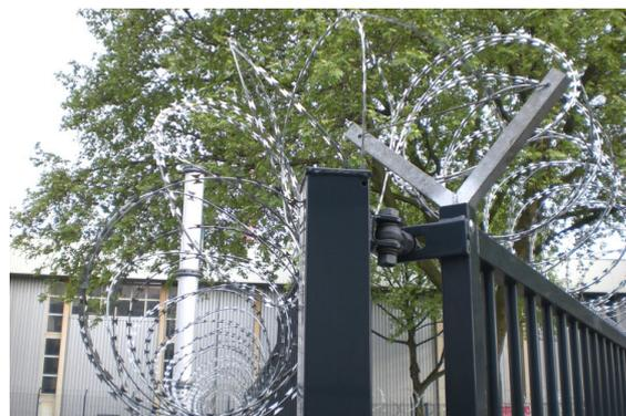
Im Vergleich zum herkömmlichen Stacheldraht verfügt der Widerhakensperrdraht nicht über „einfache“ Stacheldrahtdornen sondern über rasiermesserscharfe Klingen/Schneiden.
